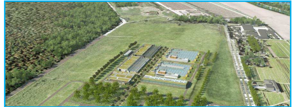
Figure 74 : Aménagements paysagers au niveau de la zone membranaire
